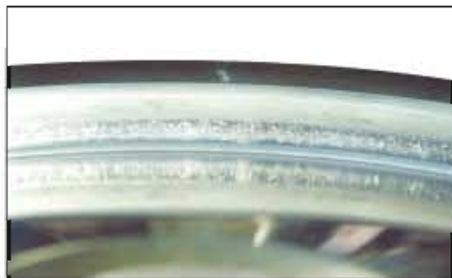
照片3-3 ● 推力圆锥滚子轴承的内圈。 ● 内圈挡边上的擦伤 ● 原因是磨损粉末混入，载荷过大造成油膜破裂。
